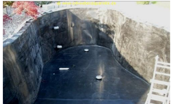
Hier sieht man wie die Einlaufrohre absolut dicht integriert sind.
