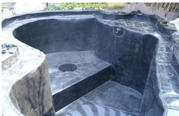
Auch Ränder auf denen später schwere Steine fixiert werden können sind herstellbar. Selber haben wir auf die Folie schon tonnenschwere Steine gestellt ohne dass es zu Folienschäden gekommen ist.
