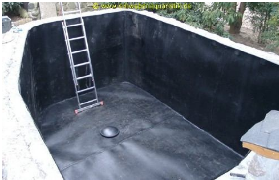
Bodenabläufe sowie ein glatter, oben abschließender Rand sind problemlos machbar.
